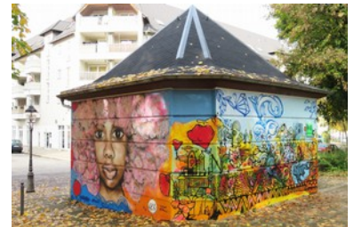
Das fertige Umspannhäuschen
