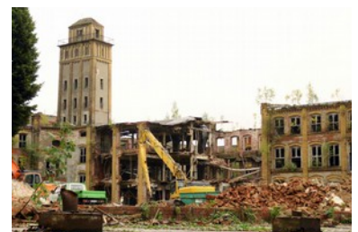
Abriss der Hochbauten in der Riemann-Fabrik
