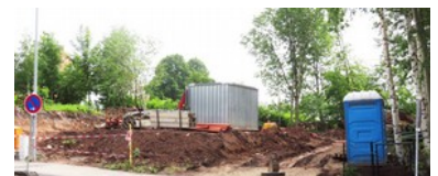
Baubeginn Hofer Straße 8
